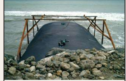
Unidades Geotube® mantenidas en su sitio por un bastidor de acero mientras son llenadas.
