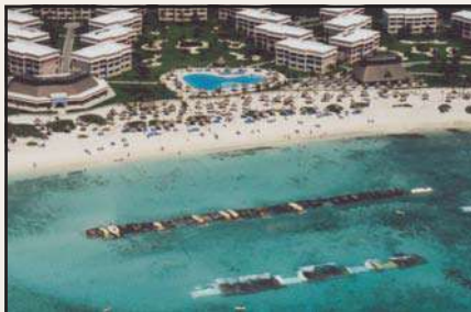
Unidades Geotube® colocadas en el mar como rompeolas.
