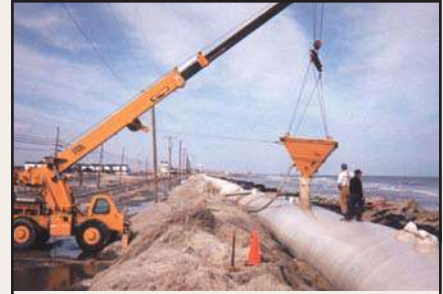
Unidad Geotube® siendo llenada con arena usando una tolva.
