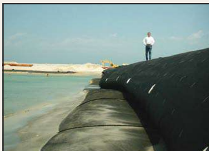
Contenedores Geotube® apilados para producir esta estructura protectora.
