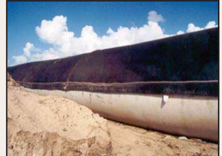
Cubiertas protectoras cubren los contenedores Geotube® de los dañinos rayos UV del sol.
