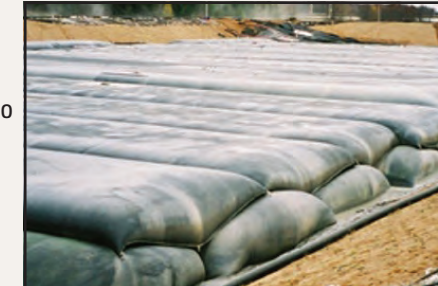
Contenedores Geotube® en la laguna de lodos activados en la planta de papel.
