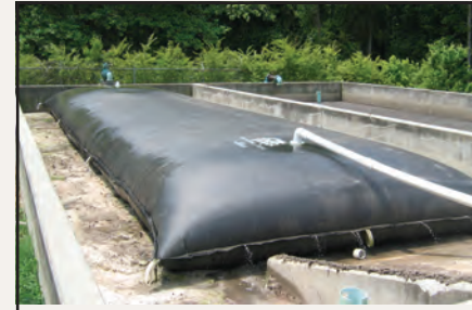
Unidades Geotube® en lechos de secado en planta municipal de tratamiento de aguas residuales.
