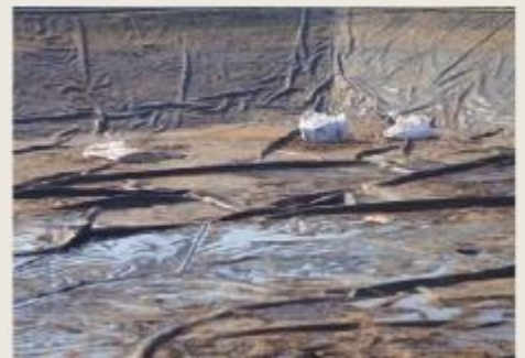
Estanque vacío para la reparación de revestimiento de HDPE
