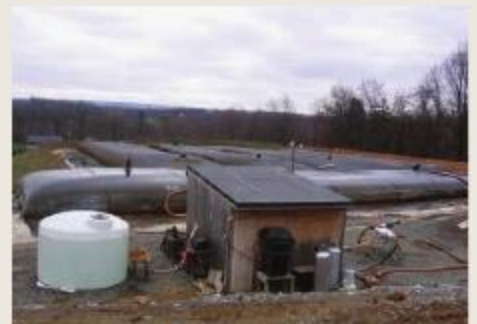
Geotubo, celda de deshidratación
